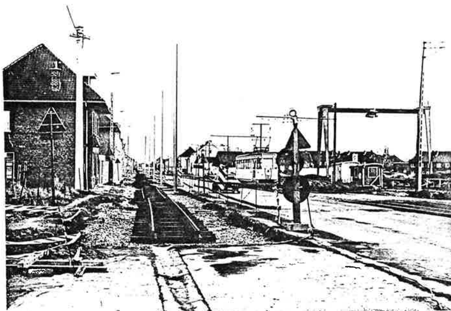
Fontaine l'Evêque : vue des travaux, le 20.11.1980
